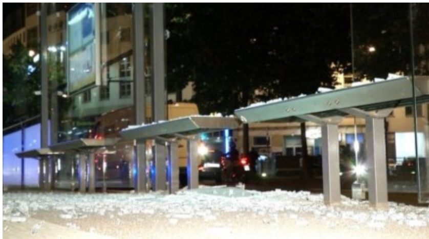
Die völlig zerstörte Bushaltestelle
