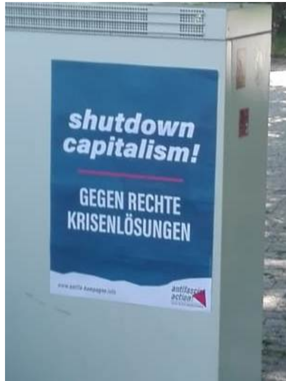
Plakate an vielen Kabelverteilerschränken.
